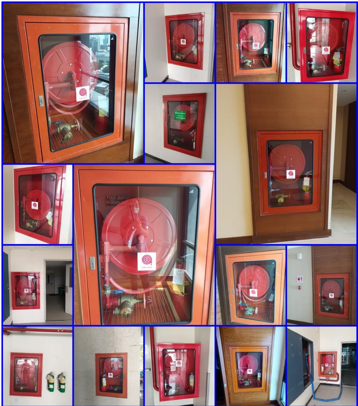
รูปที่ 12.27 เก็บสายฉีดน้ำดับเพลิงพร้อมอุปกรณ์ (FHC)
