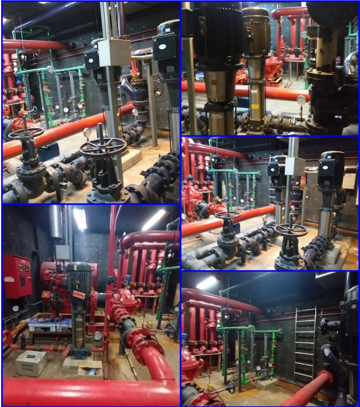
รูปที่ 12.14 โครงการมีระบบสูบน้ำประปาจากชั้นใต้ดินขึ้นไปพักน้ำที่ชั้นน้ำประปาดาดฟ้า ด้วยเครื่องสูบน้ำประปาจำนวน 2 เครื่อง
