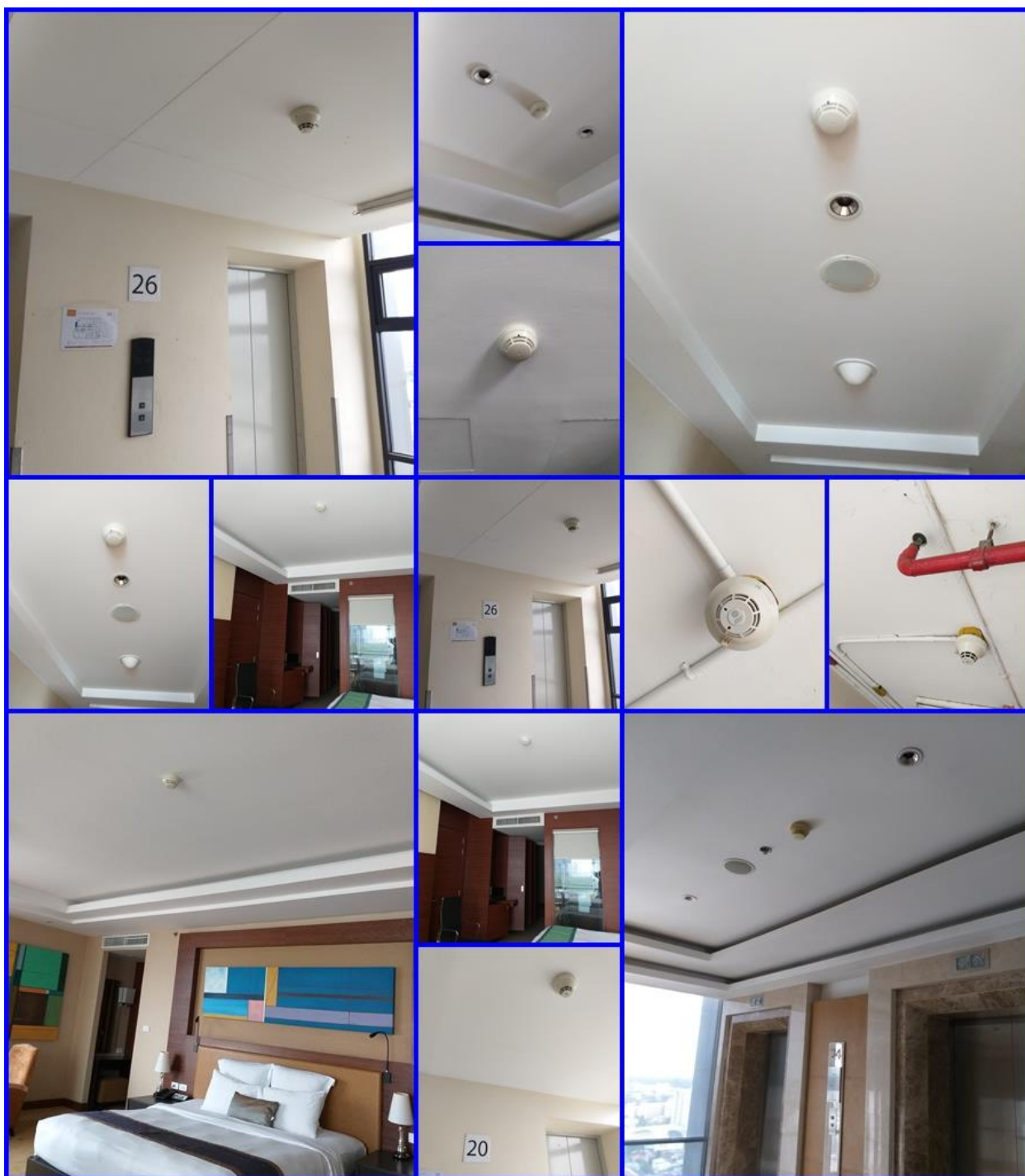
รูปที่ 12.36 เครื่องตรวจจับความร้อน ของโครงการ
