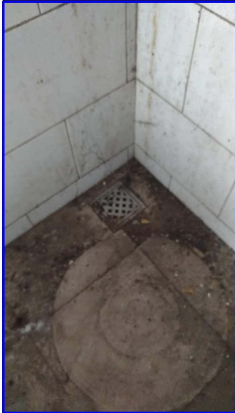
รูปที่ 12.21 ห้องพักมูลฝอยรวมมีช่องระบายน้ำทิ้งลงท่อรวมน้ำทิ้งเพื่อเข้าสู่ระบบบำบัดน้ำเสียของโครงการ
