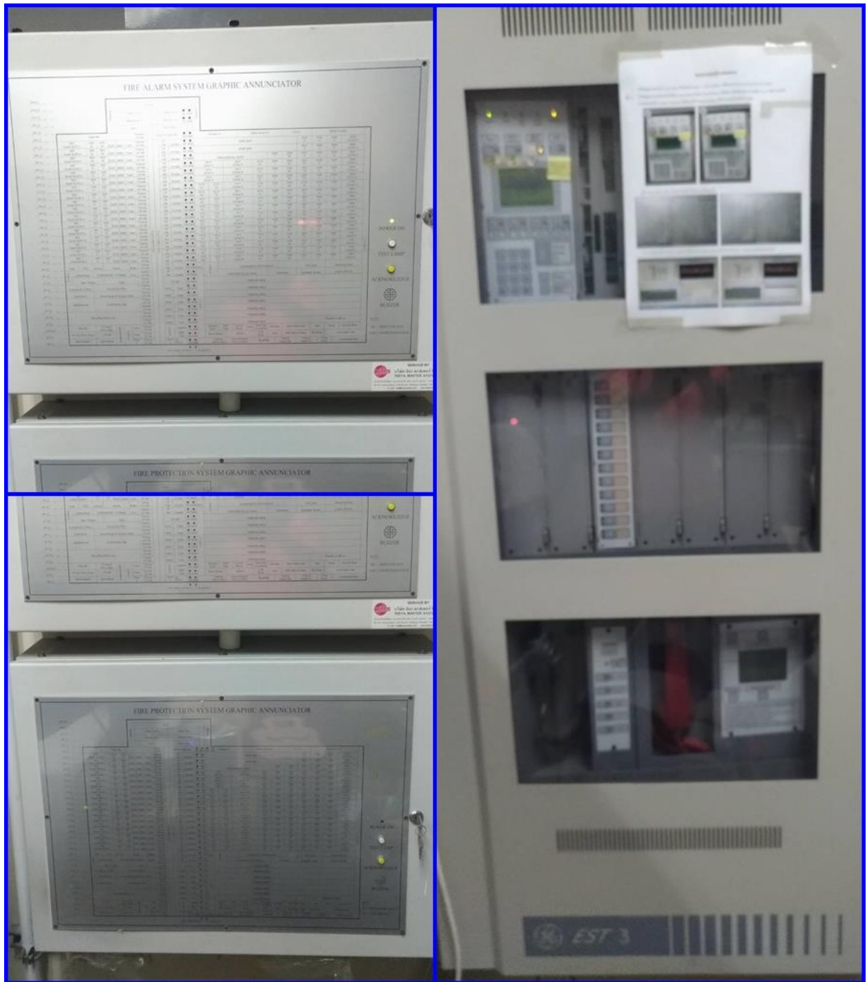
รูปที่ 12.34 Fire Alarm Control Panel : FCP
