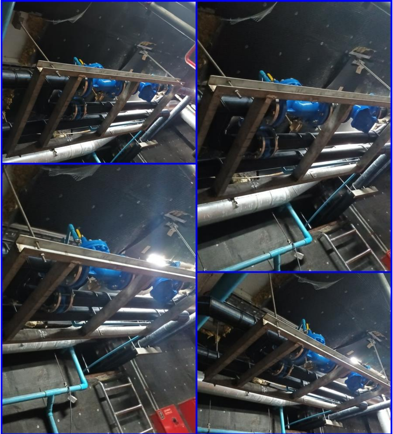
รูปที่ 12.13 รับน้ำประปาจากท่อจ่ายน้ำประปาของการประปานครหลวงมาเก็บในถังเก็บน้ำใต้ดิน ของโครงการ ด้วยการต่อท่อระบบน้ำประปขนาด 4 นิ้ว
